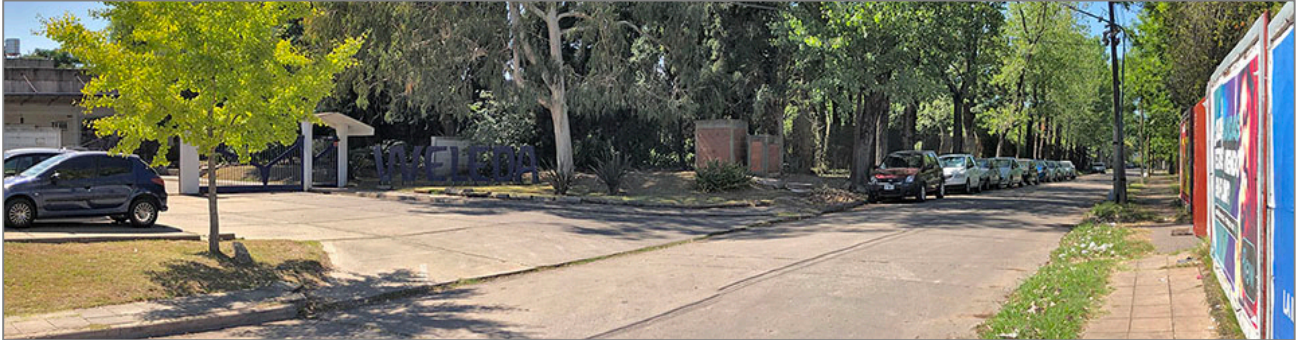
Calle Ramos Mejía – Losas de hormigón en muy buen estado de mantenimiento frente al predio – Espacios amplios de maniobra
